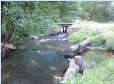
Unterwasser der Anlage 203i – mit Hilfe von Holzeinbauten wurde aus einer ehemaligen Auskolkung einen Rückzugsbereich für Jungfische gestaltet.
