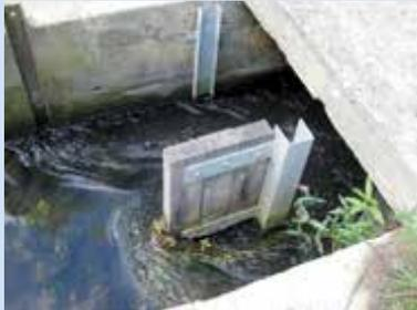
Die Schlitzpasstafeln für den Abbau des Wasserstandsunterschiedes wurden direkt in die bestehenden Stauanlagen eingebaut. Die seitlich abgewinkelten Leitwände unterbinden eine Querströmung direkt am Schlitz, die den Organismen den Aufstieg erschwert.
