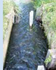
Um den erforderlichen Abfluss zu gewährleisten, werden die Schlitzpasstafeln überströmt. Der Wasserstandsabbau je Becken beträgt ca. 7cm. In Niedrigwasserperioden ist das Setzen zusätzlicher Stauböhlen vorgesehen, um die geplanten Stauhöhen zu gewährleisten.
