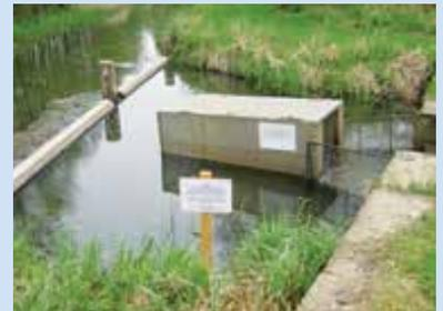
Das bestehende Abflussprofil des Kabelgrabens ist für die derzeitige Abflussverteilung überdimensioniert. Um punktuell die Strömungsgeschwindigkeit zu erhöhen und Schlammablagen auszutragen, wurden im besonders strukturarmen Oberlauf des Gewässers 27 Elemente aus Totholz eingebaut.
