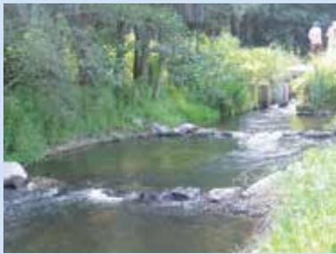
Die Steinriegel im Unterwasser der Anlagen 203o und 203j sorgen dafür, dass auch im Niedrigwasserfall die erforderlichen Wasserstände gehalten werden.
